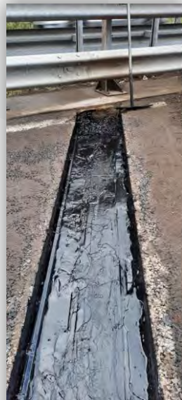
Giunto a Tampone con Profondità Superiore a quella Standard
